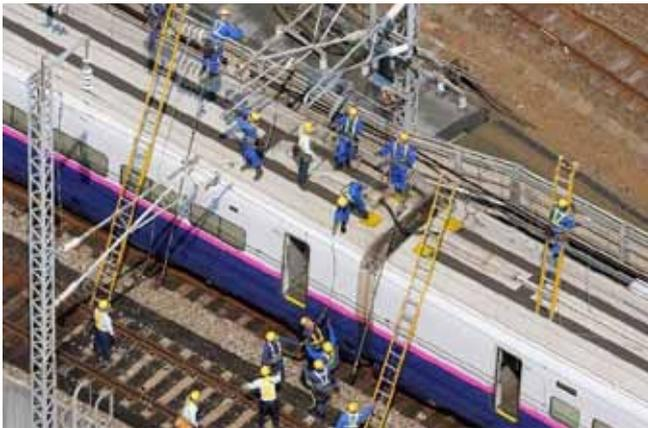
1月23日、東北新幹線大宮～上野間での架線トラブルで停電し、終日の運転見合わせとなりました。架線を引っ張る重りの設備（重錘ロッド）が壊れて架線が垂れ下がったことが原因だと報じられています。
